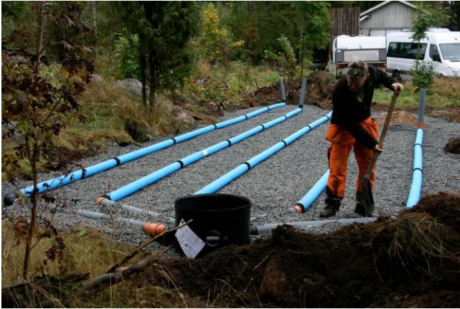
Infiltrationssslanger (til to huse, og lidt dårlig plads i længden - derfor fem stk.). Her lagt i terræn på udgravet grusbædd. Bliver dækket med jordvold. Foto: Flemming Batting
