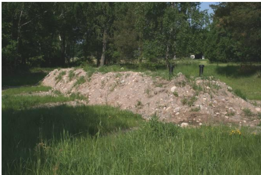
Færdig hel nyanlagt markbädd (til ét hus) placeret med infiltrationsslangerne lidt over terræn og opsamlingsrørene ca. 30 cm under terræn. Pumpe før markbädden
