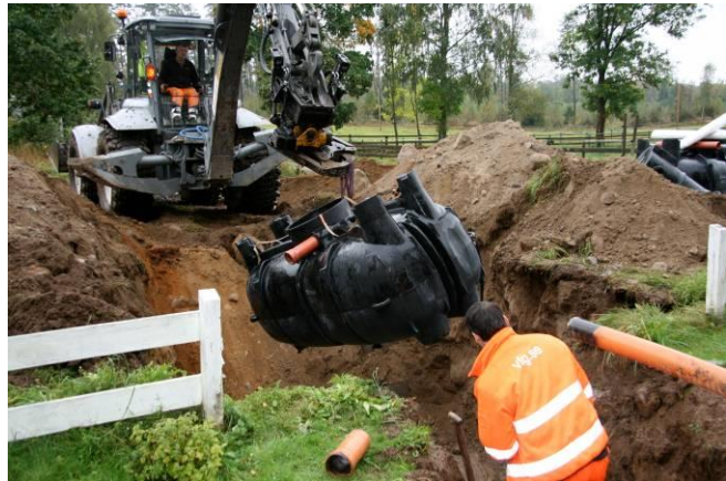
Trekammerbrønd (her af plast) hejses på plads. Foto: Flemming Batting
